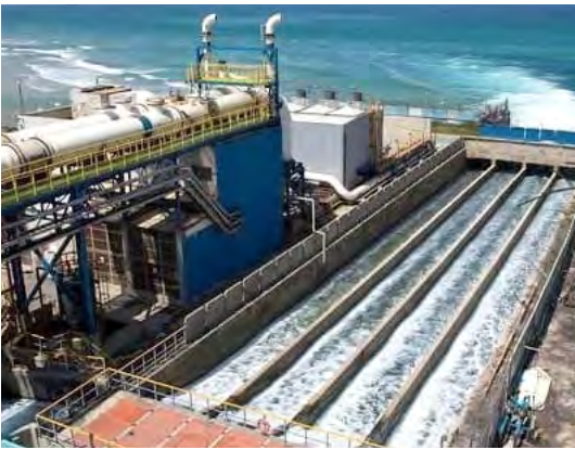
gérienne des eaux (ADE). Selon le communiqué, cet arrêt de
